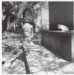
バイブレーターを使って隙間なくコンクリートを打設しているところ
