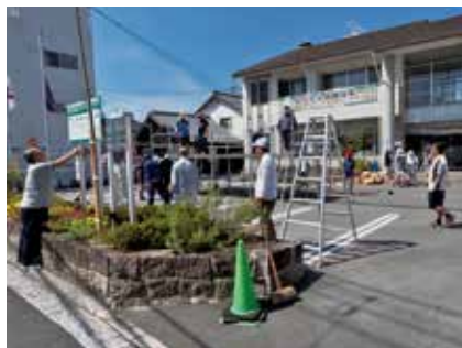
外部分電盤から電源を取り、提灯の白熱球の取り付け。並行して櫓も組み上がっている。
