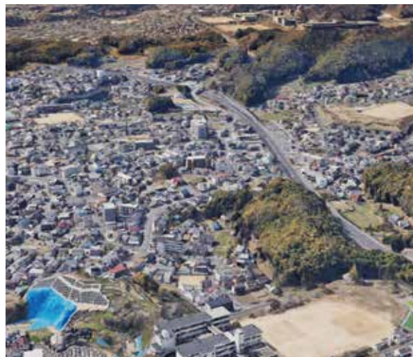
Google Earthによる鳥瞰画像。段々の石積みだった斜面が法枠工の保護斜面になっている。(画像左手前) 田んぼだったところにたくさんの住宅が軒を連ねている。丸子山が無くなっている。
