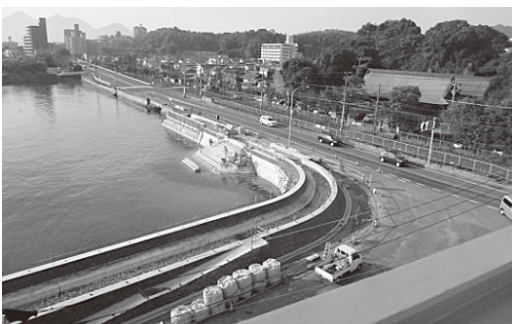
着々と進む漁港護岸工事
